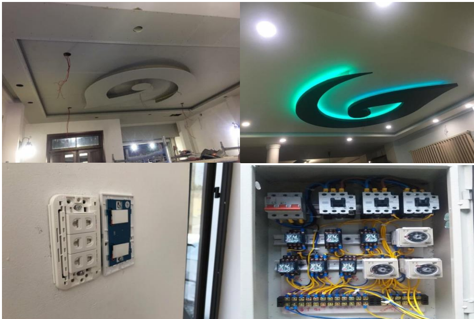
Hình 4. Lắp đặt hệ thống nhà thông minh trên thực tế
